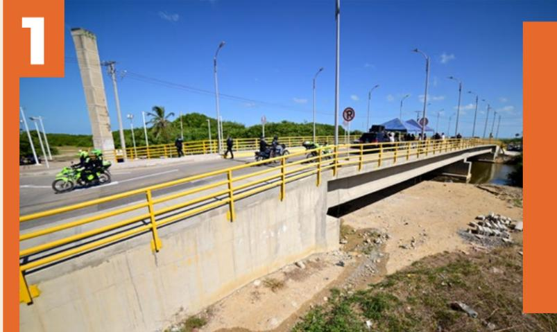
Intervinieron un área de 3.642 metros con señalización, luminarias, bordillos, andenes y rampas de acceso, entre otros elementos. Foto DPS
